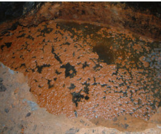
Abb. 6 Abbau, nicht versetzt mit eingestautem Grubenwasser (Fe-Ausfällungen, Gasblasen)
